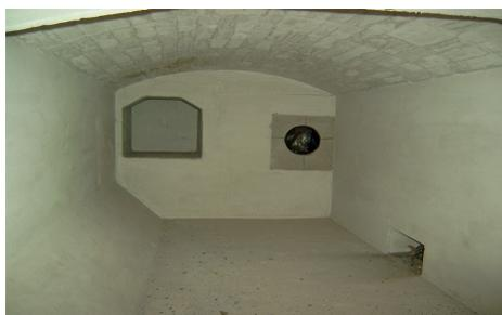
Газовая плавильная печь — материал Capiral 85 (Кэпирэл 85) используется для рабочего слоя футеровки
